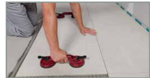
Mehr Sicherheit: Trage- und Verlegehilfen erleichtern das Handling großer Formate.
