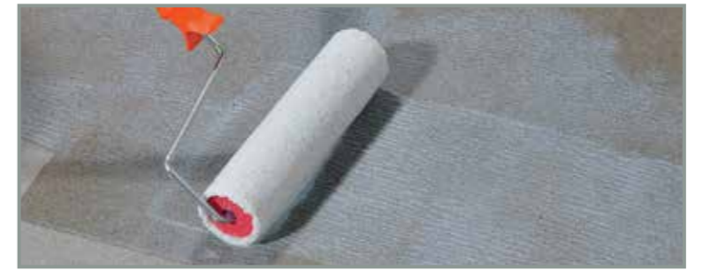
Ideal für Calciumsulfatestriche: wasserhemmende Grundierung mit ARDEX P 51.
