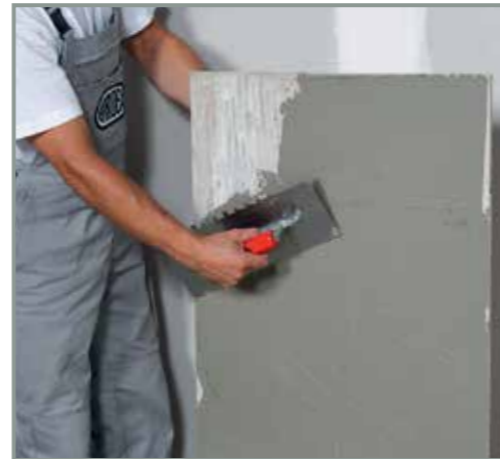
Verbesserte Haftung: mit den ARDEX MICROTEC Klebern X 78 und S 28 NEU, im Buttering-Floating-Verfahren verlegt.
