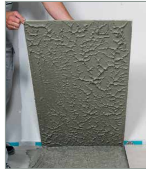
Hohlraumfreie Verlegung: durch nahezu vollständige Benetzung der Fliesenrückseite.
