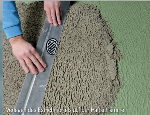
Verlegen des Estrichmörtels auf der Haftschlämme.
